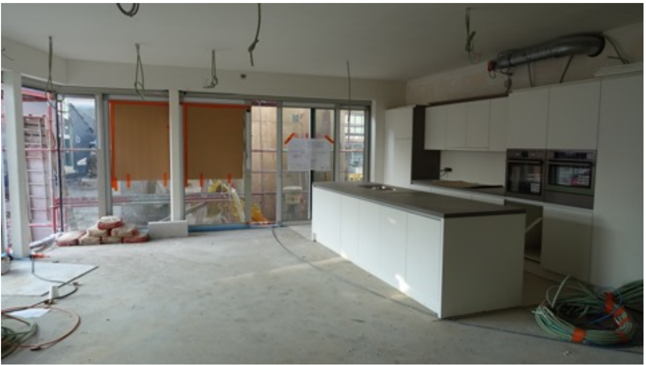
De keuken in opbouw in een van onze gemeenschappelijke ruimtes in het nieuwe beginnhof.
